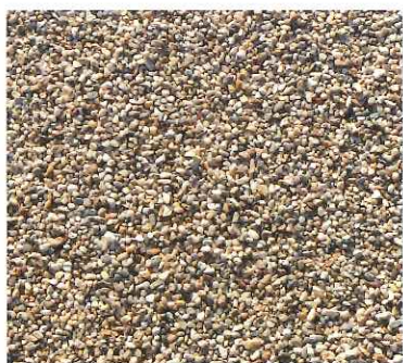
砂利敷き仕上(淡路)※
